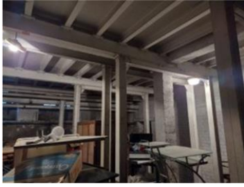
Abri avec poutres en acier
