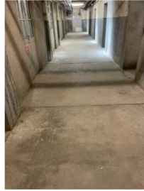
Structure du bâtiment en béton dans les sous-sol en béton
