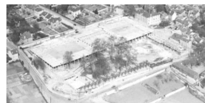
Lycée en cours de construction avec la plate-forme en béton
