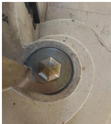
Rambarde des escaliers
